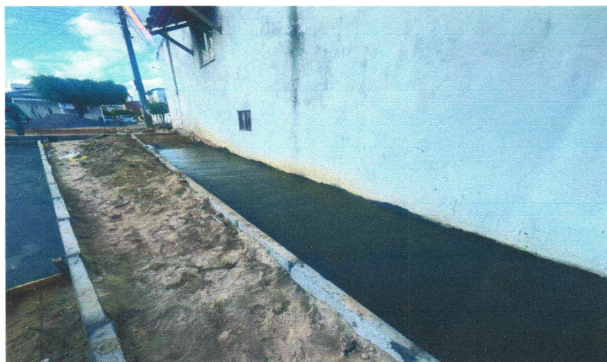
Foto 01 – PAVIMENTAÇÃO EM CONCRETO, COM ESPESSURA DE 7 CM, COM ACABAMENTO FEITO UTILIZANDO ALISADORA DE CONCRETO (HELICÓPTERO), INCLUÍDO TELA DE AÇO SOLDADA NERVURADA CA60, Q196 (3,11 KG/M²), DIÂMETRO DO FIO 5.0 MM, LARGURA = 2,45 M, ESPAÇAMENTO DA MALHA = 10 X 10 CM, JUNTA DE DILATAÇÃO EM PVC A CADA 2,00 M, CONCRETO FCK = 20 MPa
