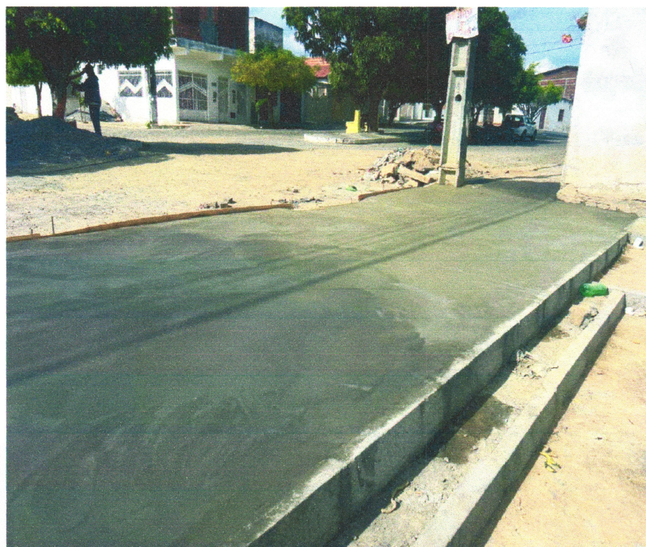
Foto 03 – PAVIMENTAÇÃO EM CONCRETO, COM ESPESSURA DE 7 CM, COM ACABAMENTO FEITO UTILIZANDO ALISADORA DE CONCRETO (HELICOPTERO), INCLUIDO TELA DE AÇO SOLDADA NERVURADA CA60, Q196 (3,11 KG/M2), DIAMETRO DO FIO 5.0 MM, LARGURA = 2,45 M, ESPAÇAMENTO DA MALHA = 10 X 10 CM, JUNTA DE DILATAÇÃO EM PVC A CADA 2,00 M, CONCRETO FCK = 20 MPA
