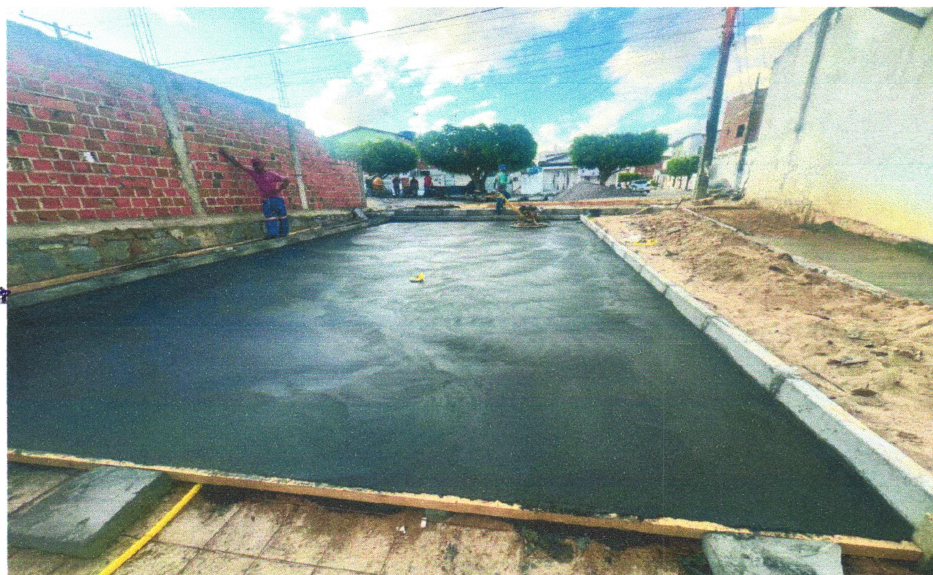
Foto 04 – PAVIMENTAÇÃO EM CONCRETO, COM ESPESSURA DE 7 CM, COM ACABAMENTO FEITO UTILIZANDO ALISADORA DE CONCRETO (HELICOPTERO), INCLUIDO TELA DE AÇO SOLDADA NERVURADA CA60, Q196 (3,11 KG/M2), DIAMETRO DO FIO 5.0 MM, LARGURA = 2,45 M, ESPAÇAMENTO DA MALHA = 10 X 10 CM, JUNTA DE DILATAÇÃO EM PVC A CADA 2,00 M, CONCRETO FCK = 20 MPA
